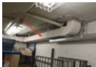
asbestcement luchtkanalen
