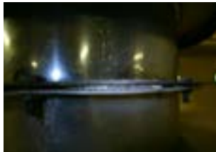
pakking als afdichting van flens (rookgas)afvoerkanaal
