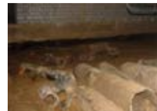
oude rioolleidingen in kruipruimte
