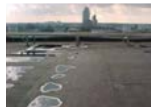
bitumen op plat dak (oude laag)
