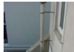
asbestcement hemelwaterafvoer-leiding
