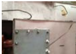
koordpakking ter afdichting van oven
