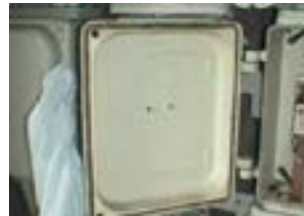
afdichtingskoord in elektrakasten
