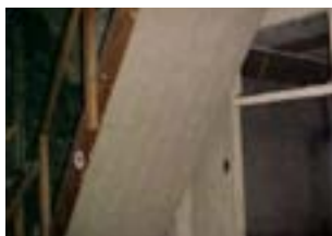
cementplaat op onderzijde trap (brandwerend materiaal)
