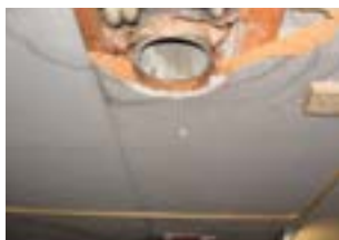
ontluchtingskanalen en ventilatieroosters
