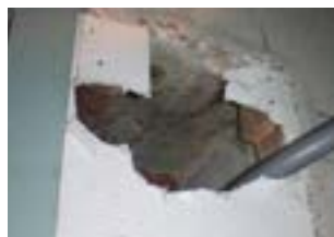
kabeldoorvoer / brandcompartimentering. Beplating heeft een honinggraat structuur
