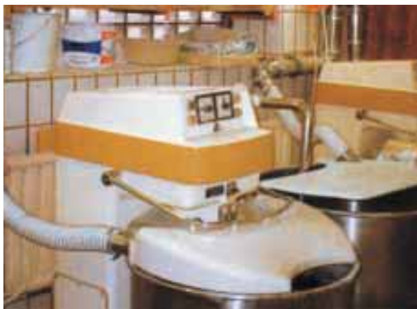
Afzuiging van een mengkuip
